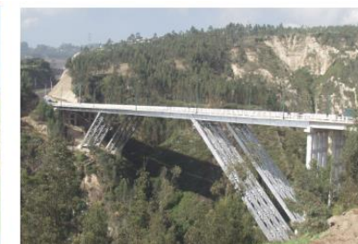
PUENTE RÍO GUALO
