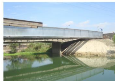
PUENTE MEJÍA - PORTOVIEJO
